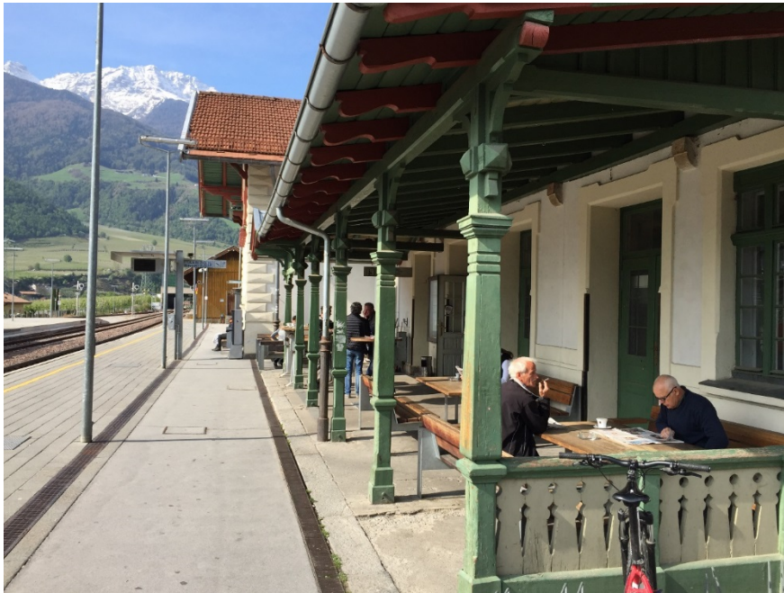
Abbildung 23: Das historische Stationsgebäude des Bahnhofs Schlanders (Vinschgau) beherbergt ein Café
